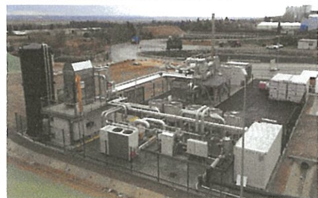
Implantation du premier moteur de valorisation du biogaz
