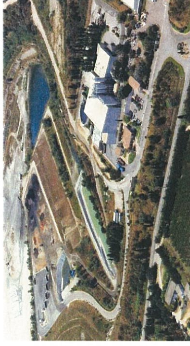
Vue de la plateforme de transit, tri et traitement des terres et mâchefers et de l'usine PSS
