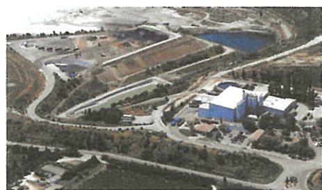
Vue de la plateforme de transit, tri et traitement des terres et mâchefers et de l'usine PSS
